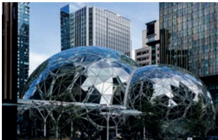
instalaciones amazon seattle.
